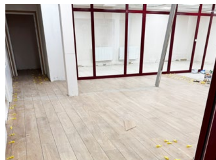
Réaménagement de l'ancienne perception (place du Chevalier de Saint-Pol)
