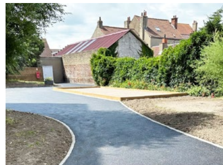
Réfection du parking et de la cour intérieure à la résidence autonomie Ambroise-Croizat (rue Chanzy)
